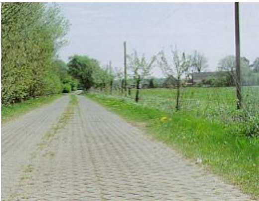
Bild 6: Vollausbau mit Rasengittersteinen
