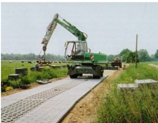
Bild 7: Einbau von UNNI-2N
