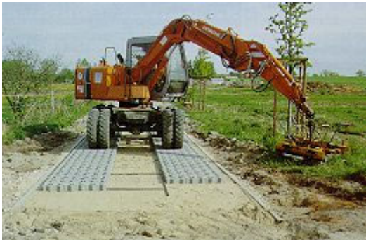
Bild 9: Verlegung mit Mobilkran
