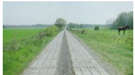
Bild 5 und 5a: Spurbahnweg mit alten Betonbahnschwellen, Bauphase und nach 11 Jahren Nutzung
