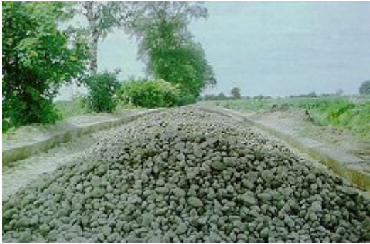
Bilder 1 und 1a: sandgeschlämmte Sammelsteintragschicht mit Randbefestigung aus Betonbahnschwellen, Bauphase und nach ca. 12 Jahren Nutzung
