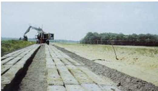
Bild 5 und 5a: Spurbahnweg mit alten Betonbahnschwellen, Bauphase und nach 11 Jahren Nutzung
