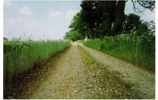
Bilder 1 und 1a: sandgeschlämmte Sammelsteintragschicht mit Randbefestigung aus Betonbahnschwellen, Bauphase und nach ca. 12 Jahren Nutzung
