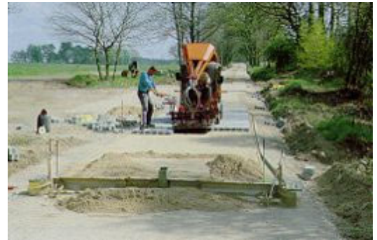
Bild 10: Verlegung mit Pflastermaschine
